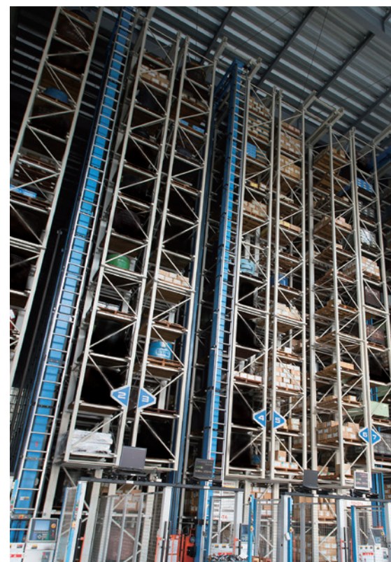
大型自動倉庫
